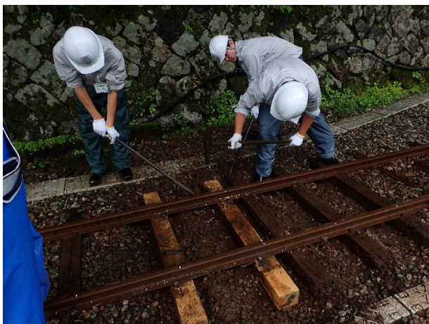
軌道での枕木交換
