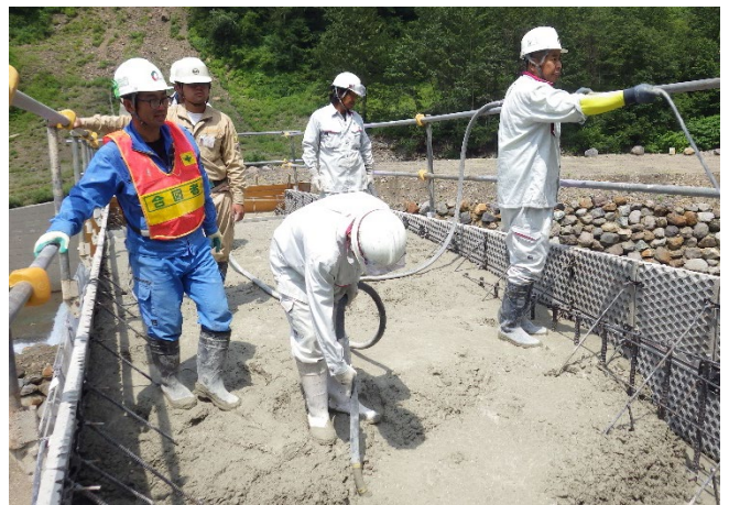
砂防堰堤のコンクリート打設
