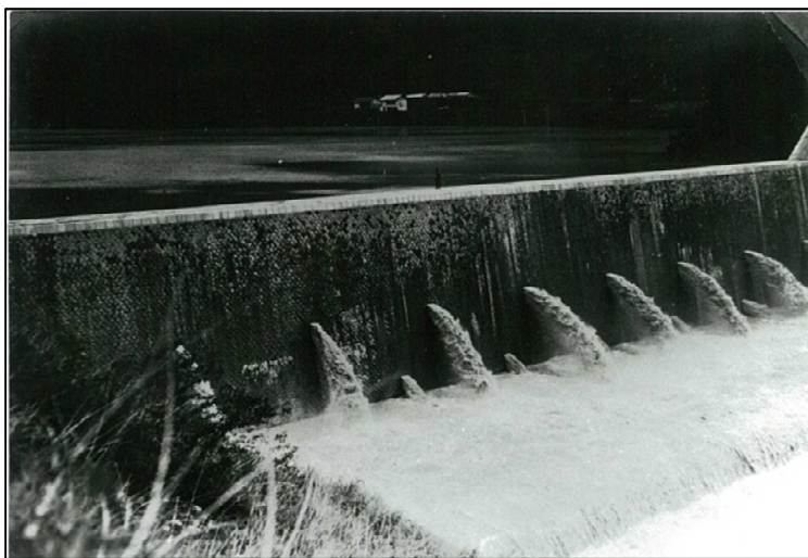
完成直後の本宮砂防堰堤 (昭和12年4月撮影)
