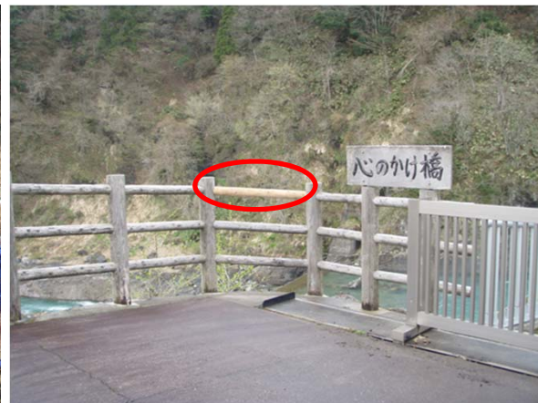
補修完了状況
