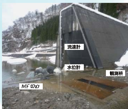
津之浦下流砂防堰堤での観測例
