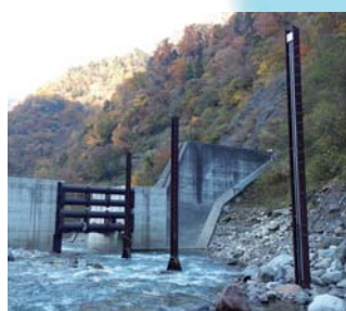
砂面計（※河床が上昇下降することを観測する計器です。土砂がどの程度貯まったか、貯まった土砂が流出したかが時間的に分かります）
