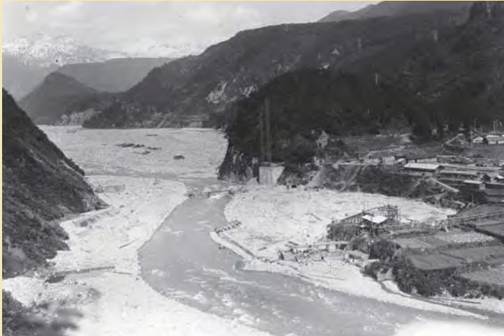
右岸下流部から見た本宮砂防堰堤の着工予定地
