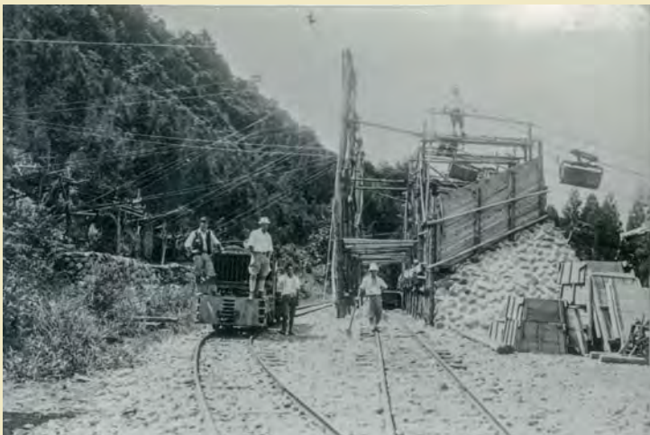
トロッコによる骨材の運搬
