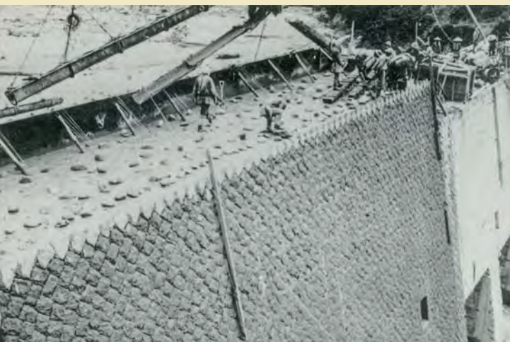
練石積みによる堰堤表面
