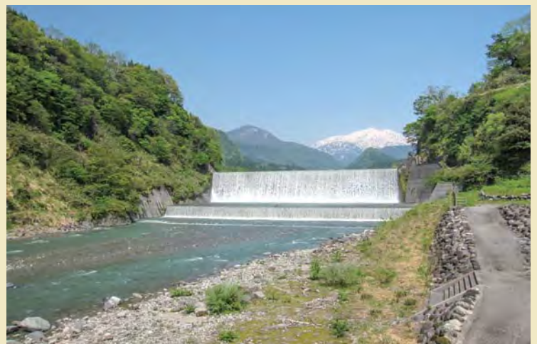
現在の本宮砂防堰堤
