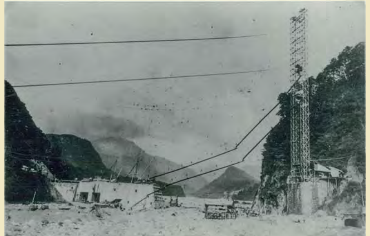
コンクリート分配タワーとシュート
