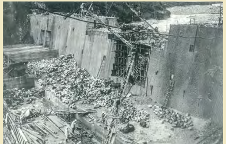
最盛期の工事状況
