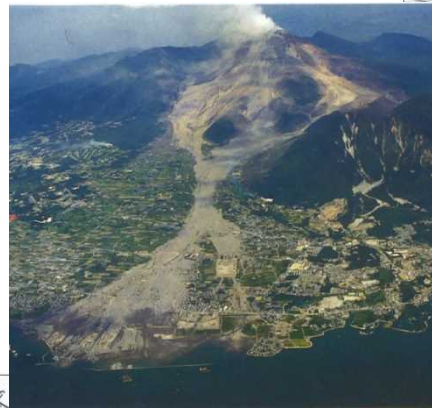
水無川流域の被災状況 (平成5年9月)
