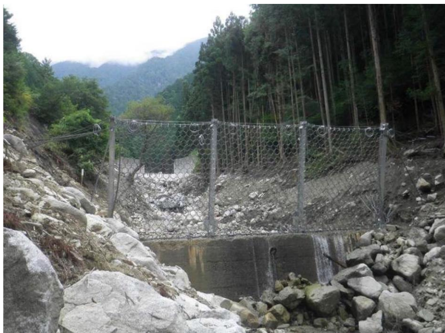
図 5-9 強靱ワイヤーネット工法（長野県南木曾町梨子沢）
