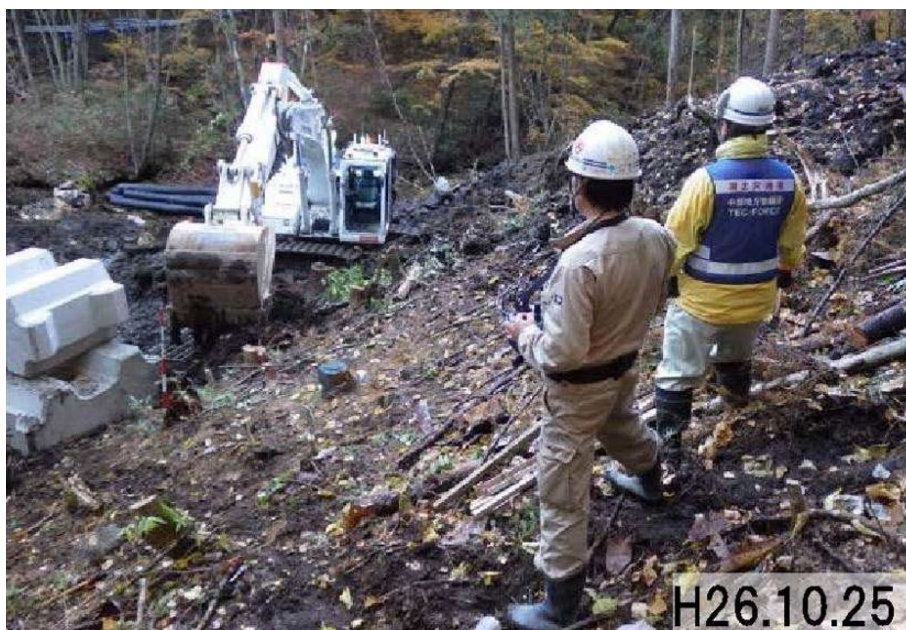
図 5-8 遠隔操作無人化施工のバックホウ（平成26年（2014年）噴火時 鹿ノ瀬川）
