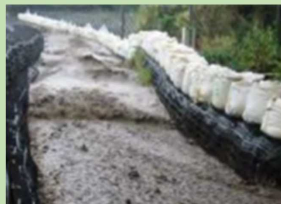
大型土のうによる導流堤
