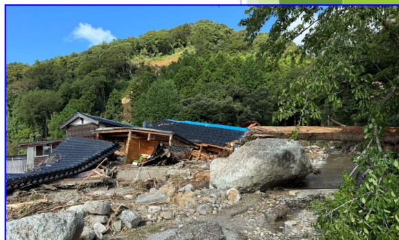
R6.9.20大雨による土石流被害：死者1名ほか （輪島市町野町南時国）
