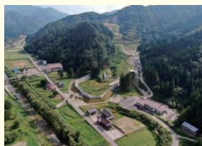
南砺市利賀村の土砂流出対策
