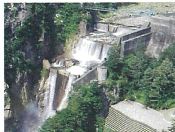
国指定 重要文化財 白岩砂防堰堤(立山砂防事務所)
