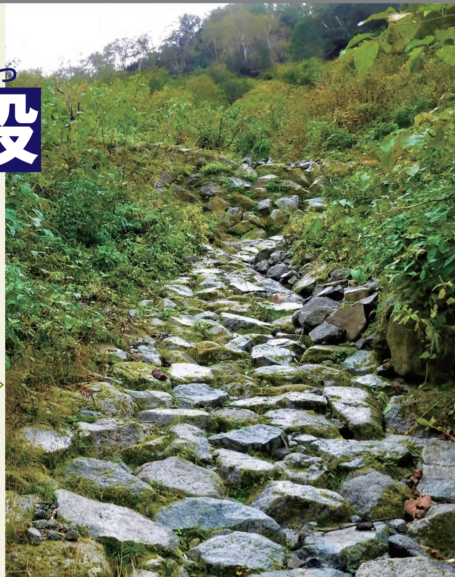
現在の西五ノ谷の石張水路工
