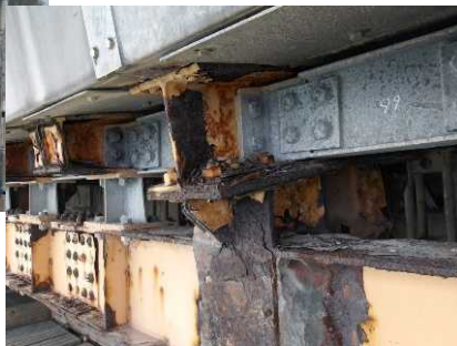
鋼材の腐食
