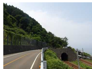
勝山トンネル（写真は東口）
