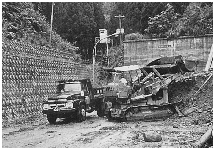
天険トンネル坑口付近
