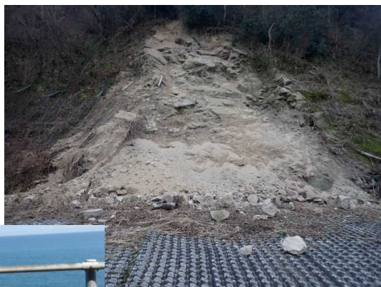
上: 洞門上部斜面の崩壊 左: 洞門の屋根を越えて点検 通路に落ちてきた石
