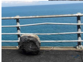
上: 洞門上部斜面の崩壊 左: 洞門の屋根を越えて点検 通路に落ちてきた石
