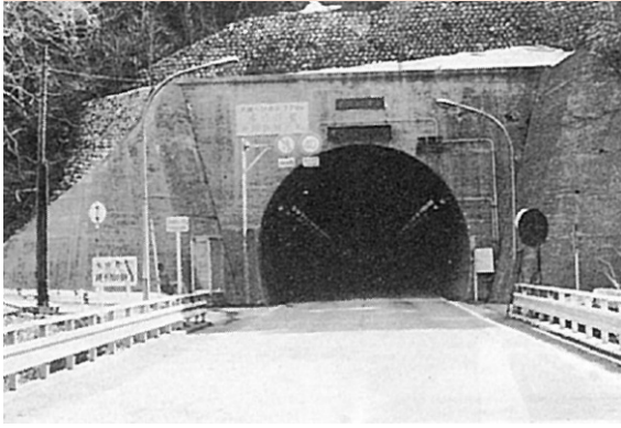
天嶮トンネル
