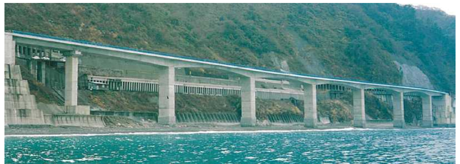
子不知高架橋
