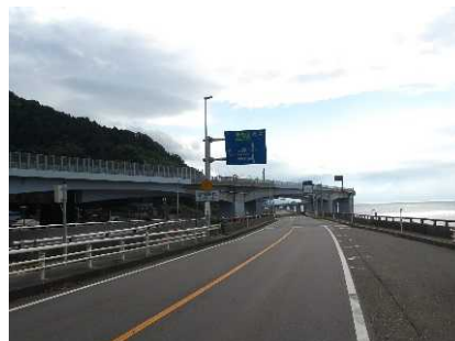
上の道路:北陸自動車道高架橋 下の道路:国道8号歌高架橋
