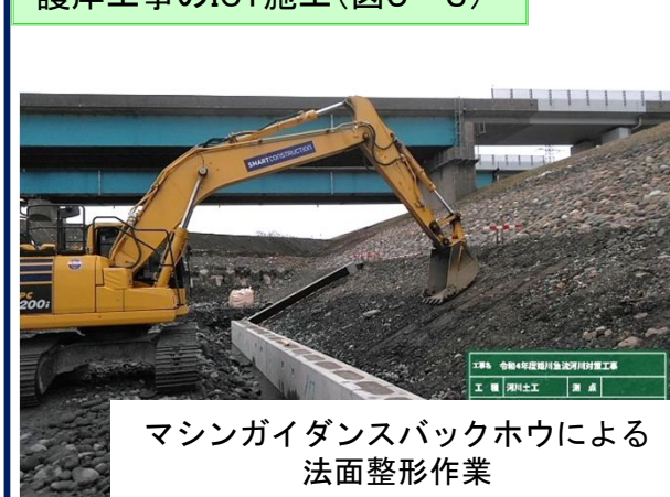
護岸工事のICT施工(図5-3)
