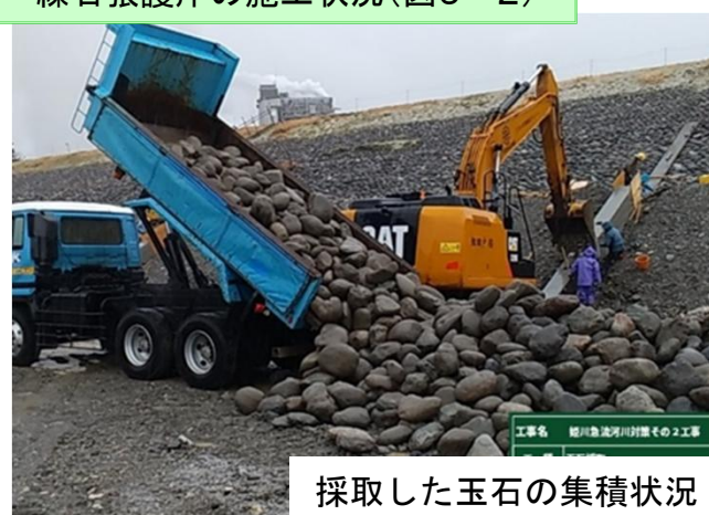
練石張護岸の施工状況(図5-2)
