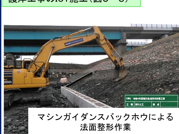
護岸工事のICT施工(図5-3)
