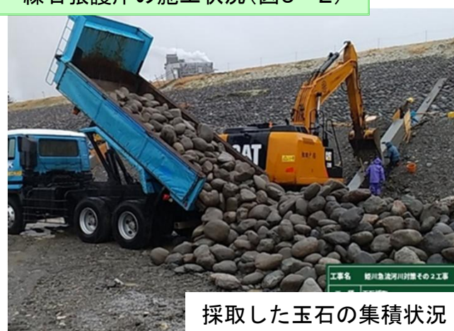
練石張護岸の施工状況(図5-2)
