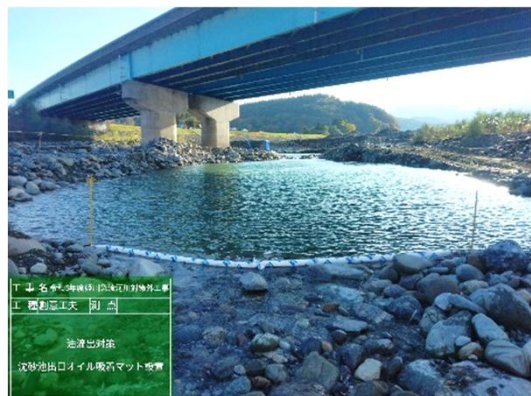
沈砂池の設置
