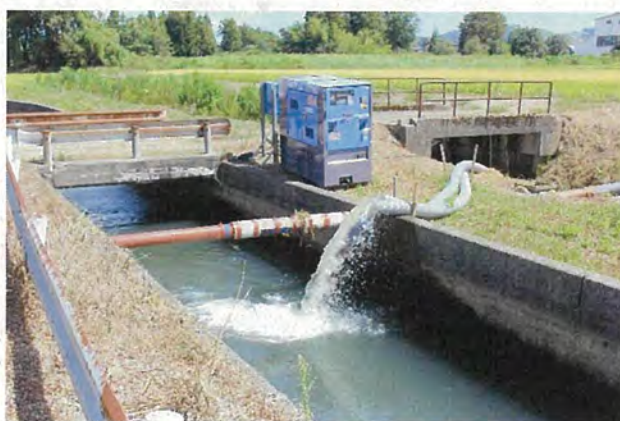
令和5年かんばつ補給ポンプの設置状況 （R5.8.25 中江幹線用水路 上越市板倉区上福田新田地内）
