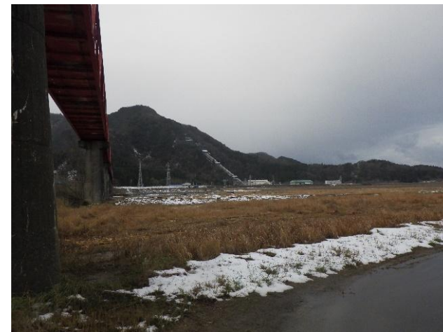
作業後(2.0k付近)
