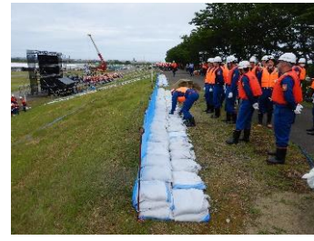
改良積み土のう工
