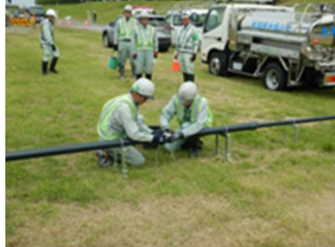
ライフライン復旧(水道)
