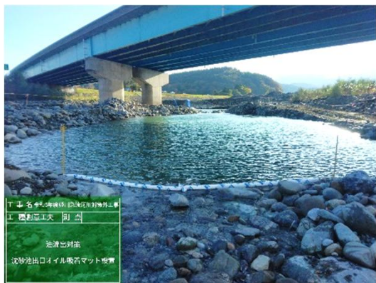
沈砂池の設置
