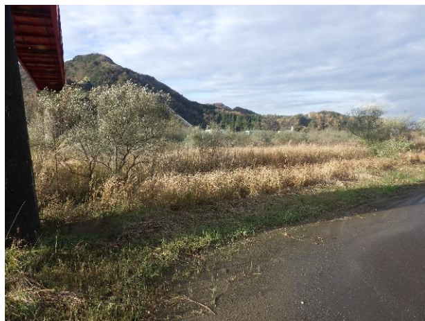
作業前(2.0k付近)
