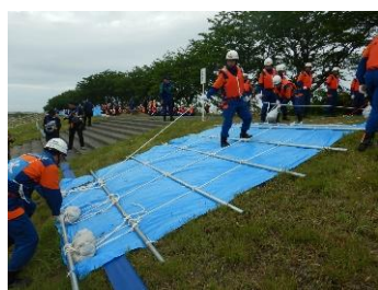
シート張り工
