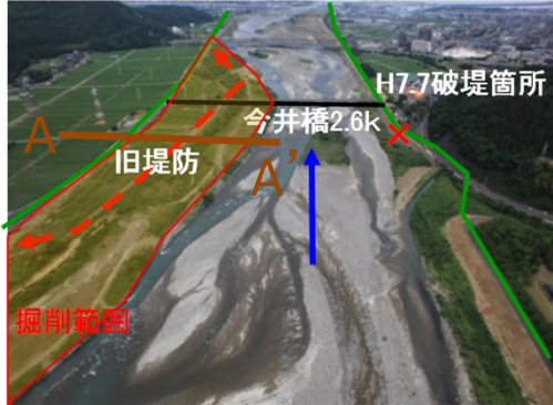
図2-7 河道掘削等整備箇所
