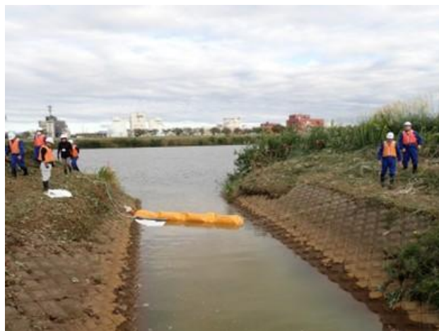
令和6年の様子(オイルフェンス設置訓練)
