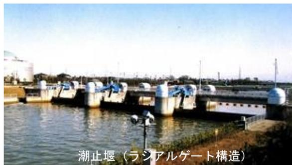
潮止堰 (ラジアルゲート構造)
