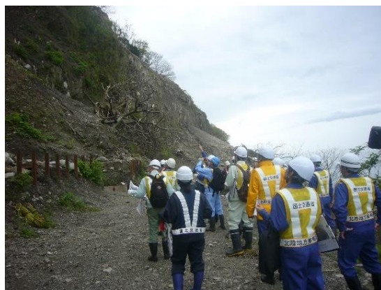
洞門上斜面の点検状況
