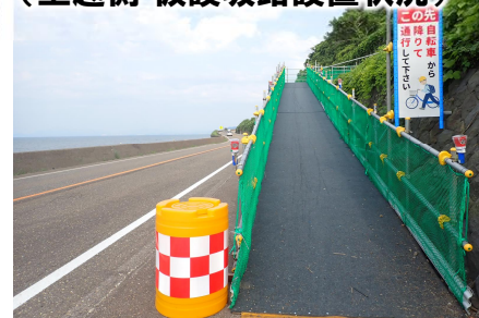
(上越側 仮設坂路設置状況)
