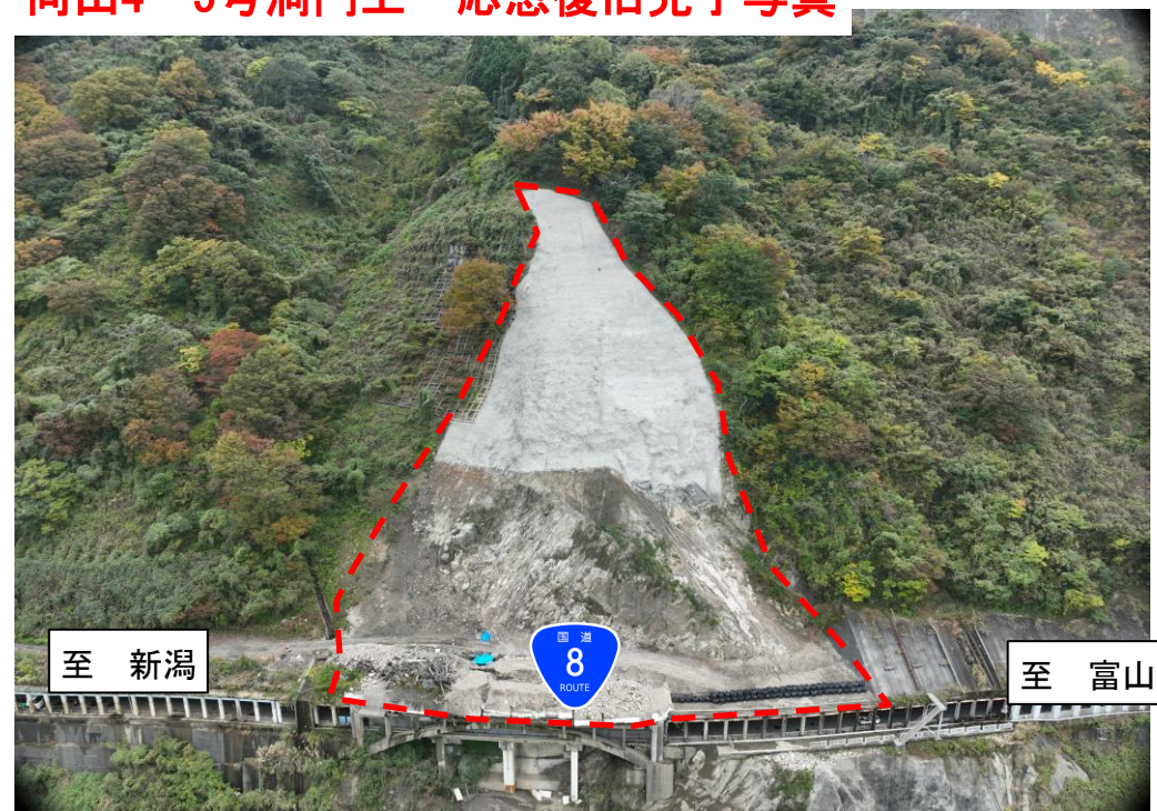
向山4・5号洞門上 応急復旧完了写真
