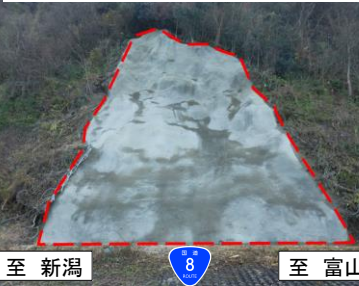
勝山11号洞門上 応急復旧完了写真
