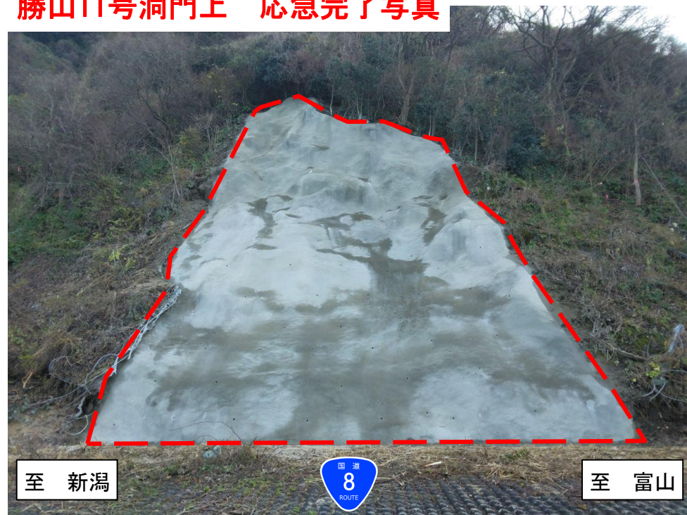
勝山11号洞門上 応急完了写真
