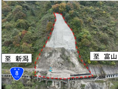
向山4・5号洞門上 応急復旧完了写真
