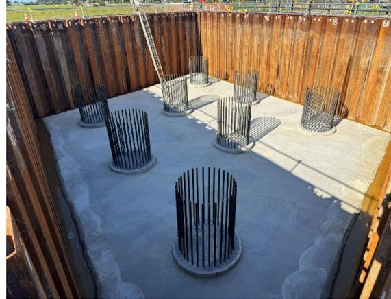
写真-2 杭頭処理完了
