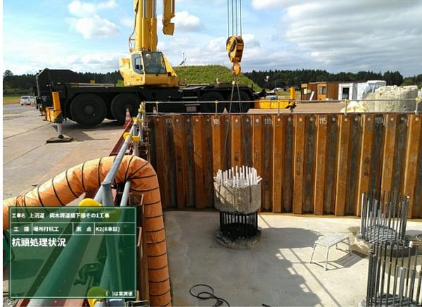
写真-1 杭頭処理状況（素抜き工法）
