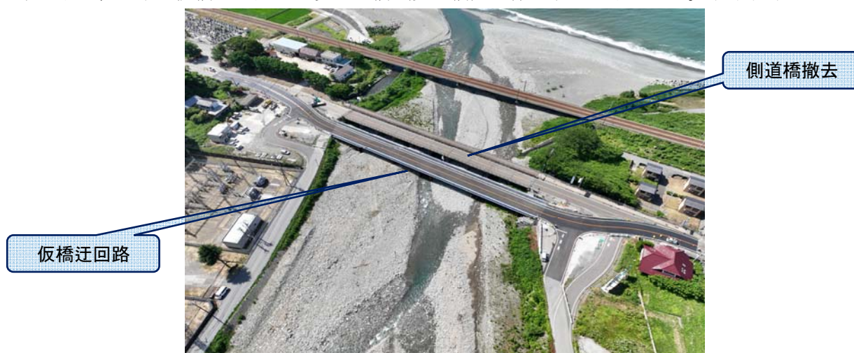
写真-1 現場全景 ※令和6年6月25日迂回路供用開始時点
