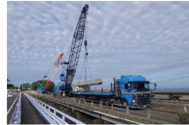
撤去桁積み込み搬出
