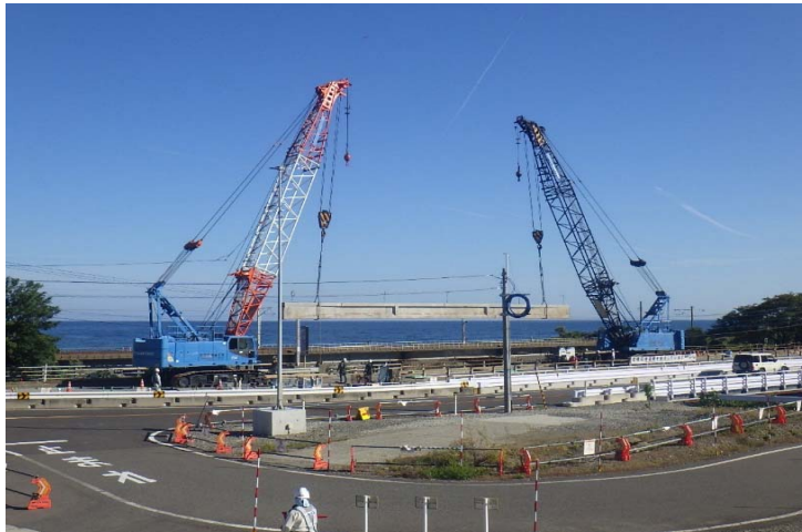
写真-6 クレーン相吊りによる桁撤去
