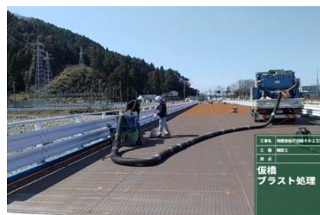
写真-3 ブラストによる処理
