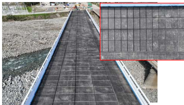
目地撤去完了
