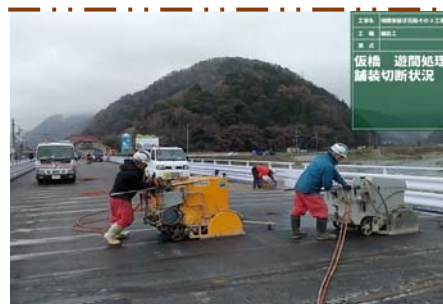
アスファルト目地切断
