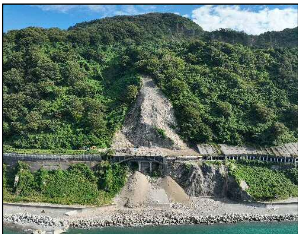
写真 - 11 土砂撤去完了
