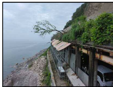
写真 - 7 洞門海側追加防護状況
