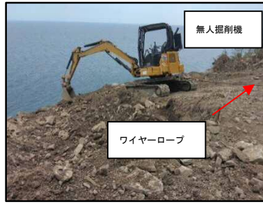
写真 - 4 堆積土砂撤去状況（1回目）
