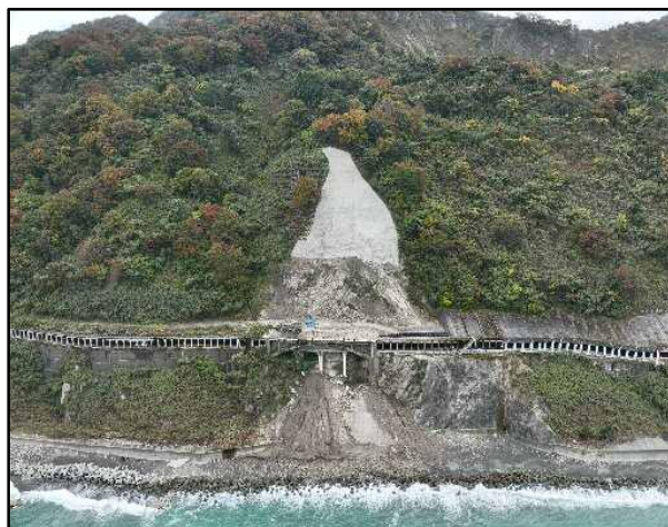
写真 - 12 応急対策完了
