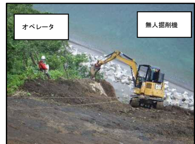
写真 - 5 法面不安定土砂掘削状況
