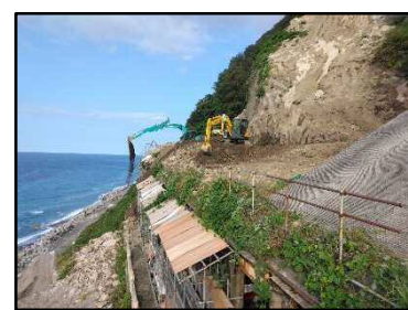
写真 - 8 洞門堆積土砂撤去状況
