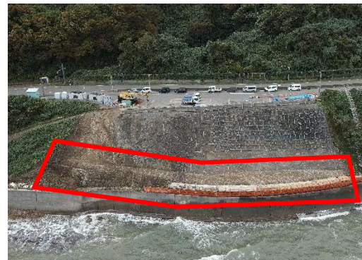
写真-11 土砂撤去後
