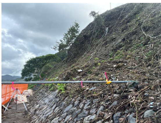
写真-5 堆積土下の石張工
