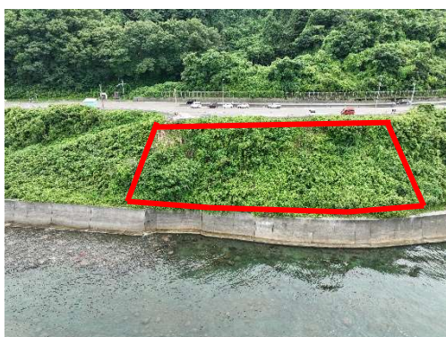
写真-1 着手前全景
