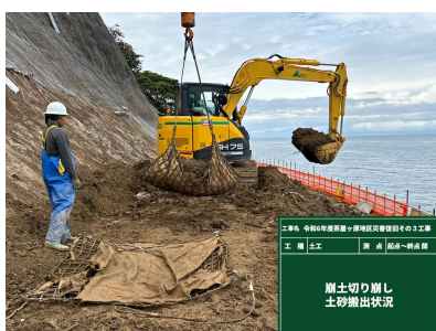
写真-6 掘削・集積状況
