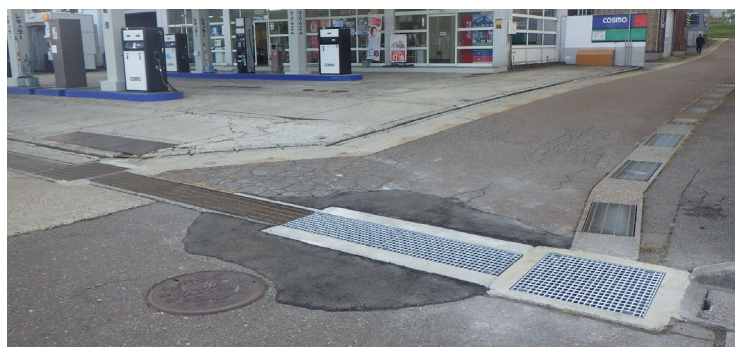
写真-2 修繕完了 (側溝上部の打替え)
