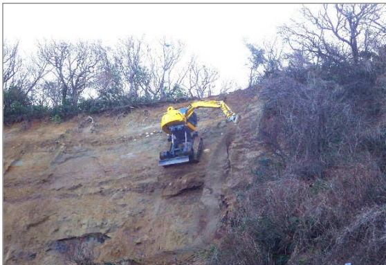
写真－３ ロッククライミングマシン作業状況
