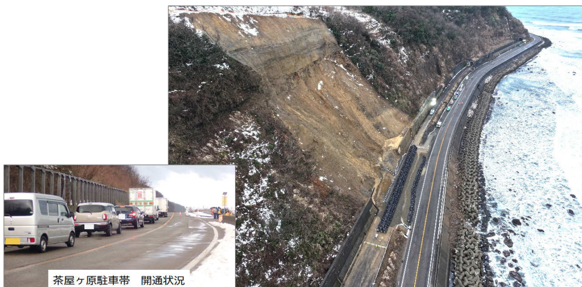
写真-9 仮復旧完了
