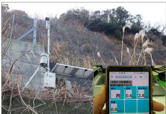
写真-7 雨量計設置
