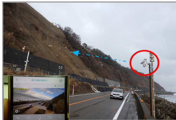
写真-8 監視カメラ設置
