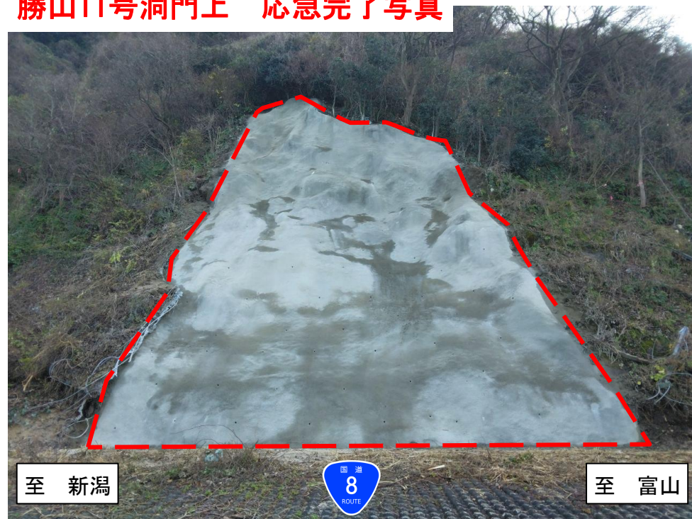
勝山11号洞門上 応急完了写真
