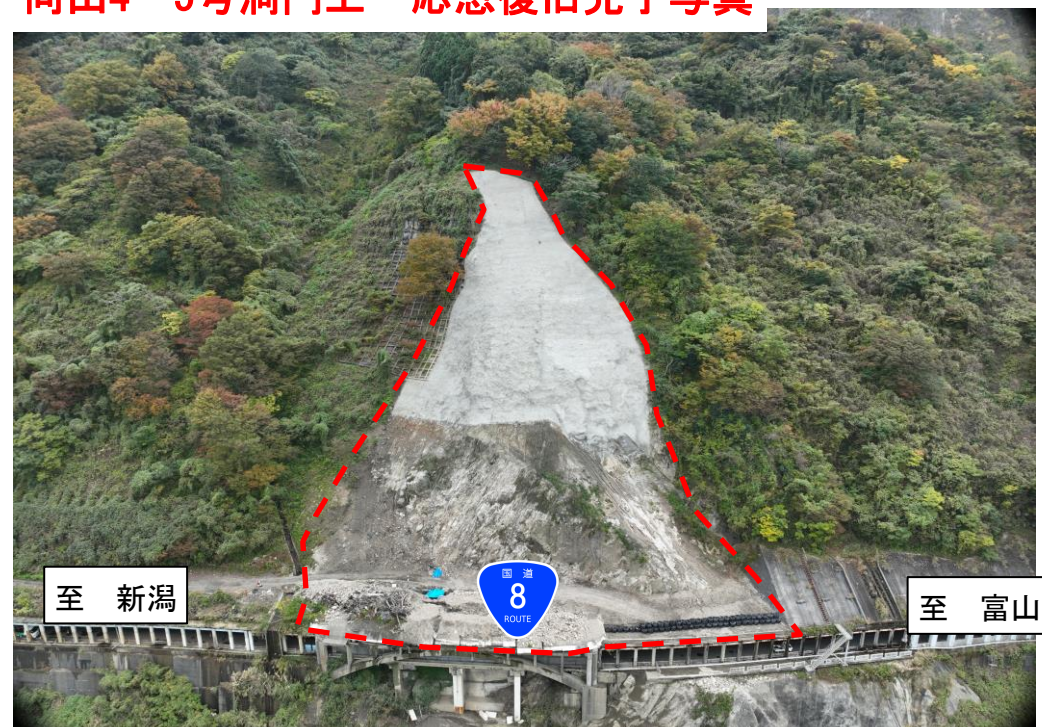
向山4・5号洞門上 応急復旧完了写真
