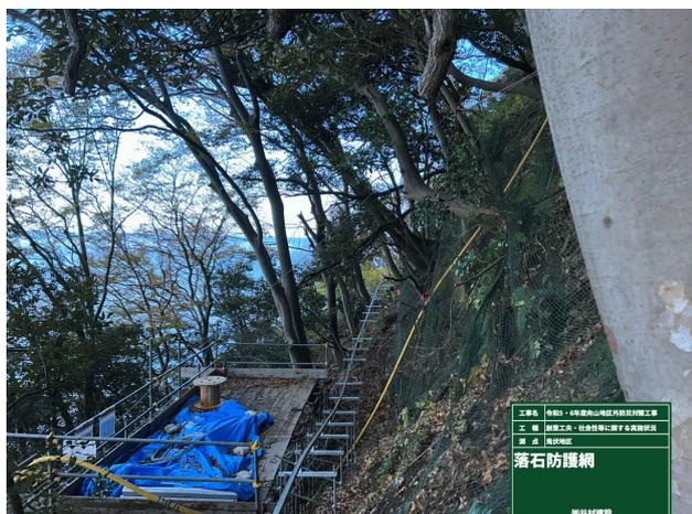
(写真-3 落石防止網設置状況)
