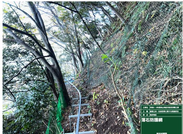
(写真-4 落石防止網設置状況)
