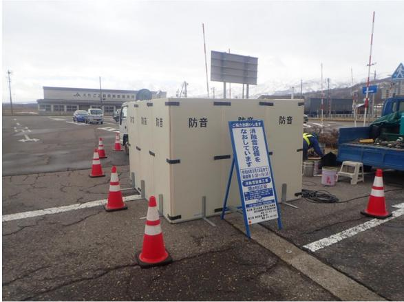
写真 1. 養生材設置状況（外観）
