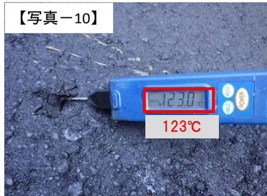
※⑥密粒度アスコン(新20FH)改質Ⅱ型 110℃以上 ①安定処理・②粗粒度アスコン(20) 100℃以上
