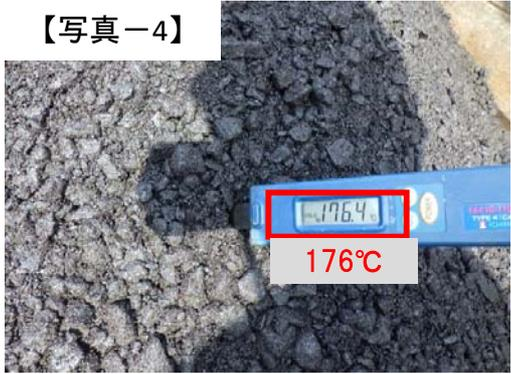
※⑥密粒度アスコン(新20FH)改質Ⅱ型 165℃以上 ①安定処理・②粗粒度アスコン(20) 145℃以上
