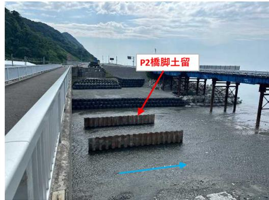
写真-5 鋼矢板短辺方向切断後
