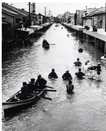
昭和40年（1965年）9月洪水 直江津駅前浸水状況
