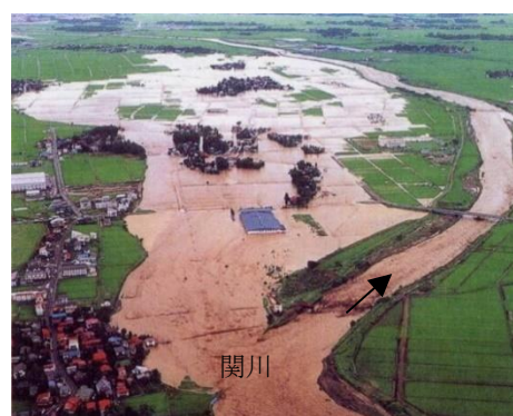
平成7年（1995年）7月洪水 つきおか 妙高市月岡地先破堤状況（旧 あらい 新井市）
