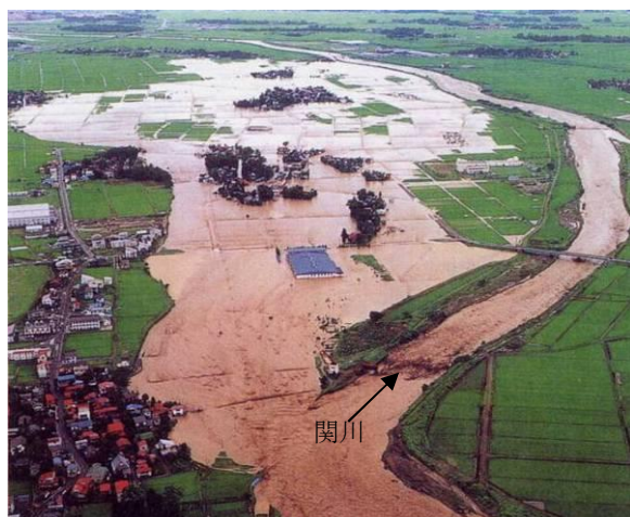
堤防決壊状況（妙高市月岡地先）
