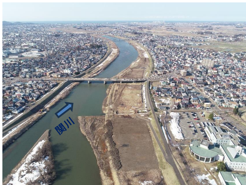
【 鴨島工区 河道掘削現場 】
