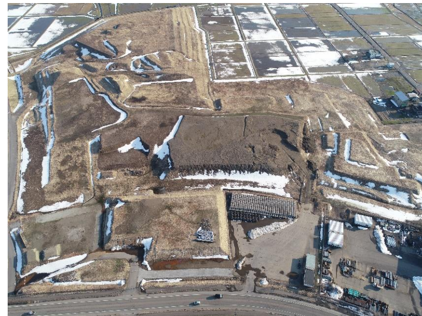
【 下箱井工区 土砂運搬現場 】
