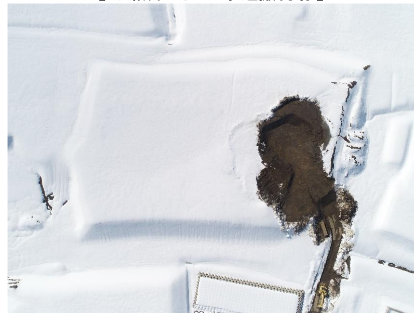
【下箱井工区 土砂運搬現場】
