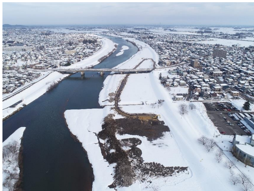
【鴨島工区 河道掘削現場】
