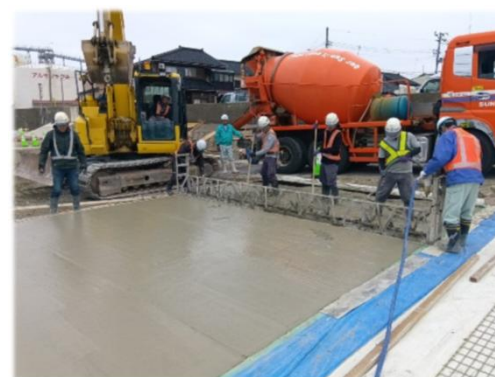
【 平張コンクリート 施工状況 】
