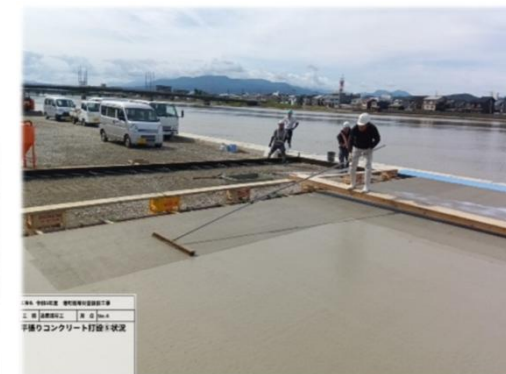
【 平張コンクリート 施工状況 】
