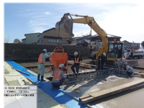
【 平張コンクリート 施工状況 】
