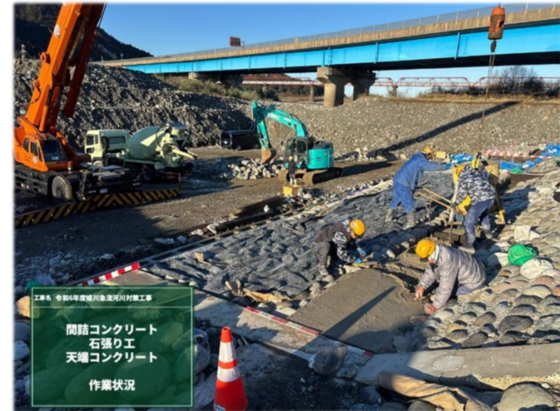
天端コンクリート作業状況
