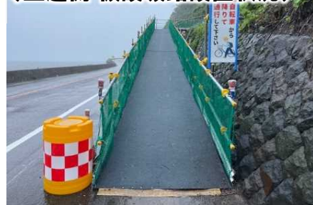
(上越側 仮設坂路設置状況)
