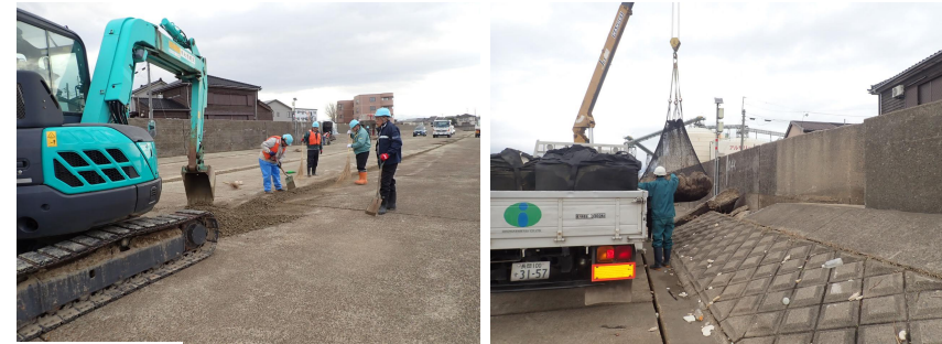
応急復旧作業状況
