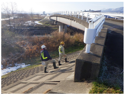
関川 2次点検 状況写真 （正善寺川合流点付近）
