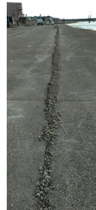
1月6日応急復旧完了
