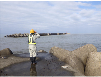
関川 2次点検 状況写真 （沖側導流堤）
