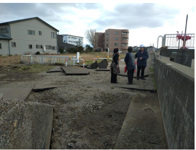
関川 職員点検及び周辺住民 聞き取り状況写真 （港町第2排水樋管付近）
