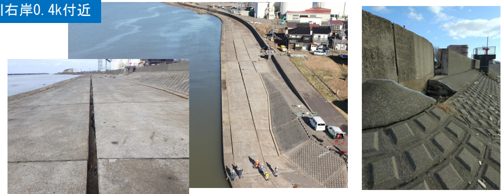
コンクリート目地の開き 及び 堤防損傷状況
