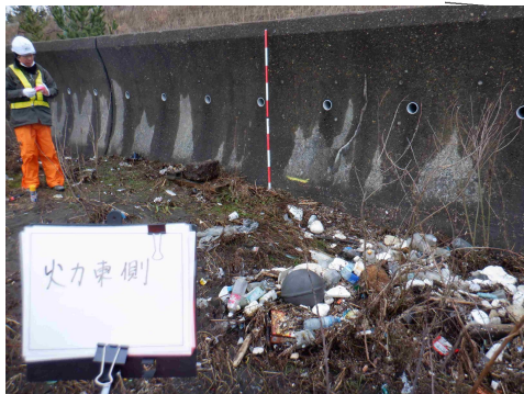
砂浜上部の痕跡高 T.P.+3.55m
