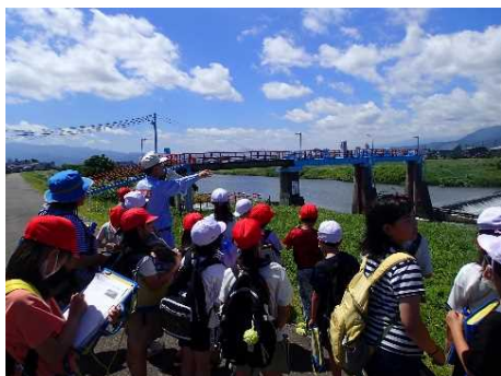
上越工業用取水堰
