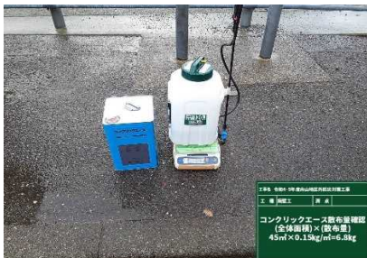
(写真-4 養生剤計量状況)
