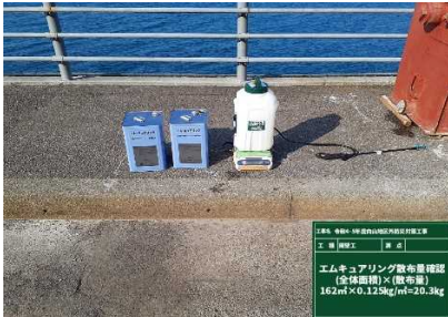
(写真-1 養生剤計量状況)
