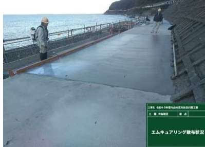
(写真-2 養生剤散布状況)
