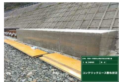
(写真-6 養生材散布完了)
