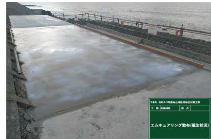
(写真-3 養生材散布完了)
