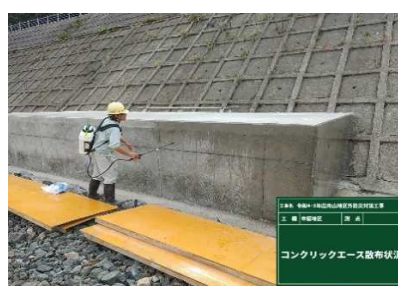
(写真-5 養生剤散布状況)
