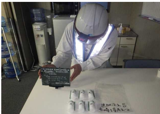
写真-3, 4 補修箇所ごとの注入確認
