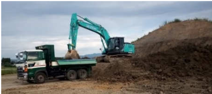
写真-3 ダンプトラックへの積込状況
