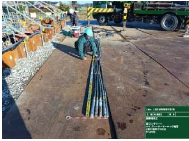
写-7 アクリル型枠による層厚・打設状況確認
