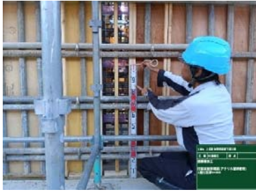
写-7 アクリル型枠による層厚・打設状況確認
