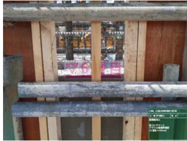
写-7 アクリル型枠による層厚・打設状況確認
